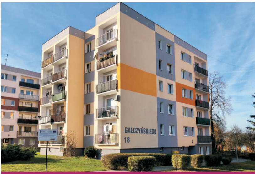
Budynek nr 18 przy ulicy Konstatego Ildefonsa Gałczyńskiego.
